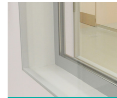
Doppelverglasung an einer bestehenden Konstruktion
